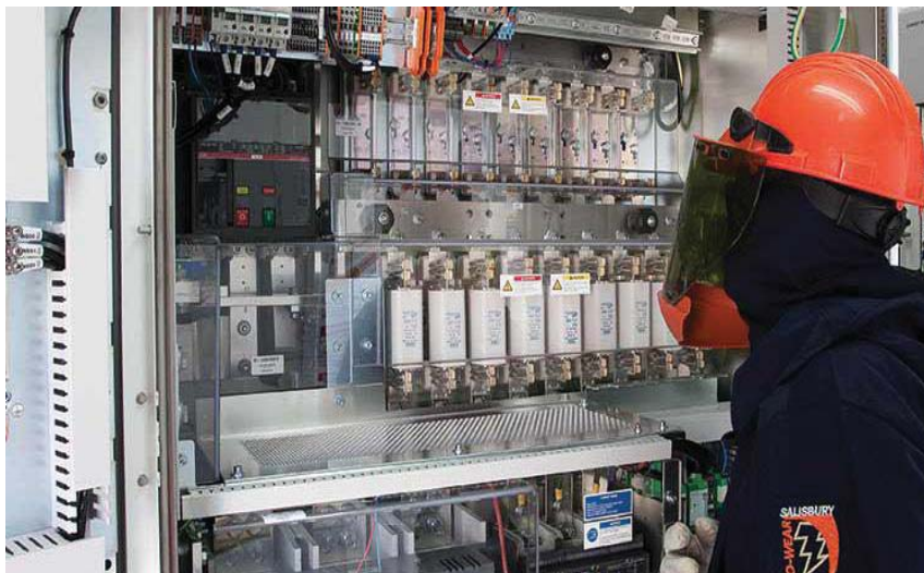
شکل ۹۲- فیوزهای اینورتر را بررسی کنید.
