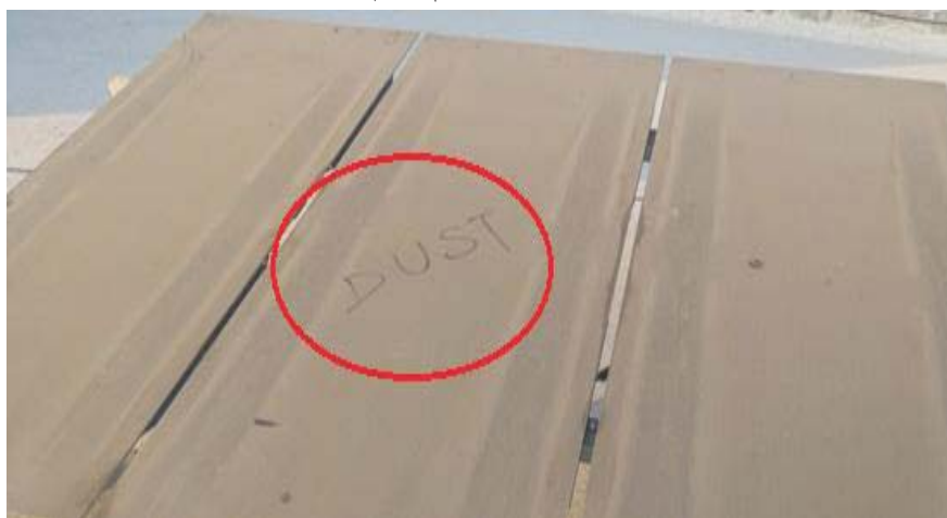
شکل ۲۴- مدول خاک گرفته به مقدار کم (عدم تحمیل بار مالی چشمگیر)
