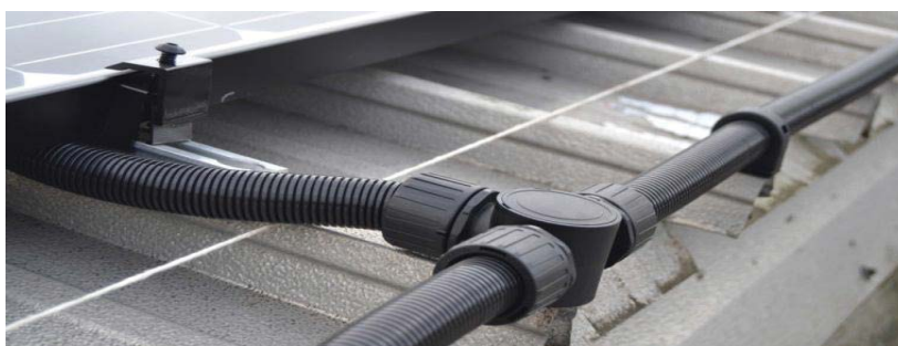
شکل ۱۱۰- نحوه صحیح عبور کاندویت
