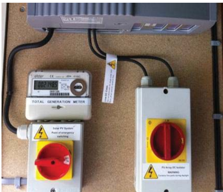
شکل ۹۵ - نمونه‌ای از وسایل حفاظت جریان بالا
