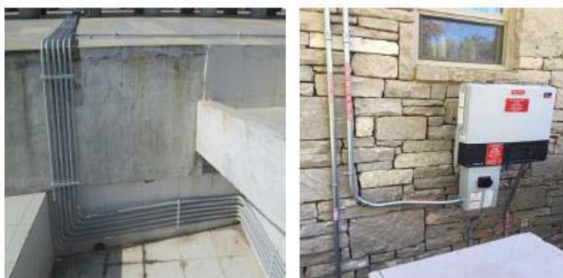
شکل ۱۰۱- مسیر مناسب نصب کابل
