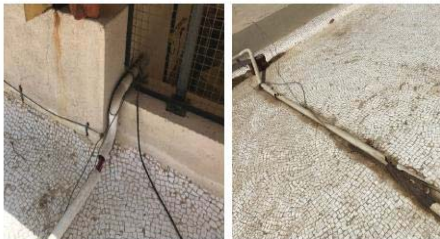
شکل ۱۰۹- نحوه اشتباه عبور کاندویت و آسیب دیدگی آن
